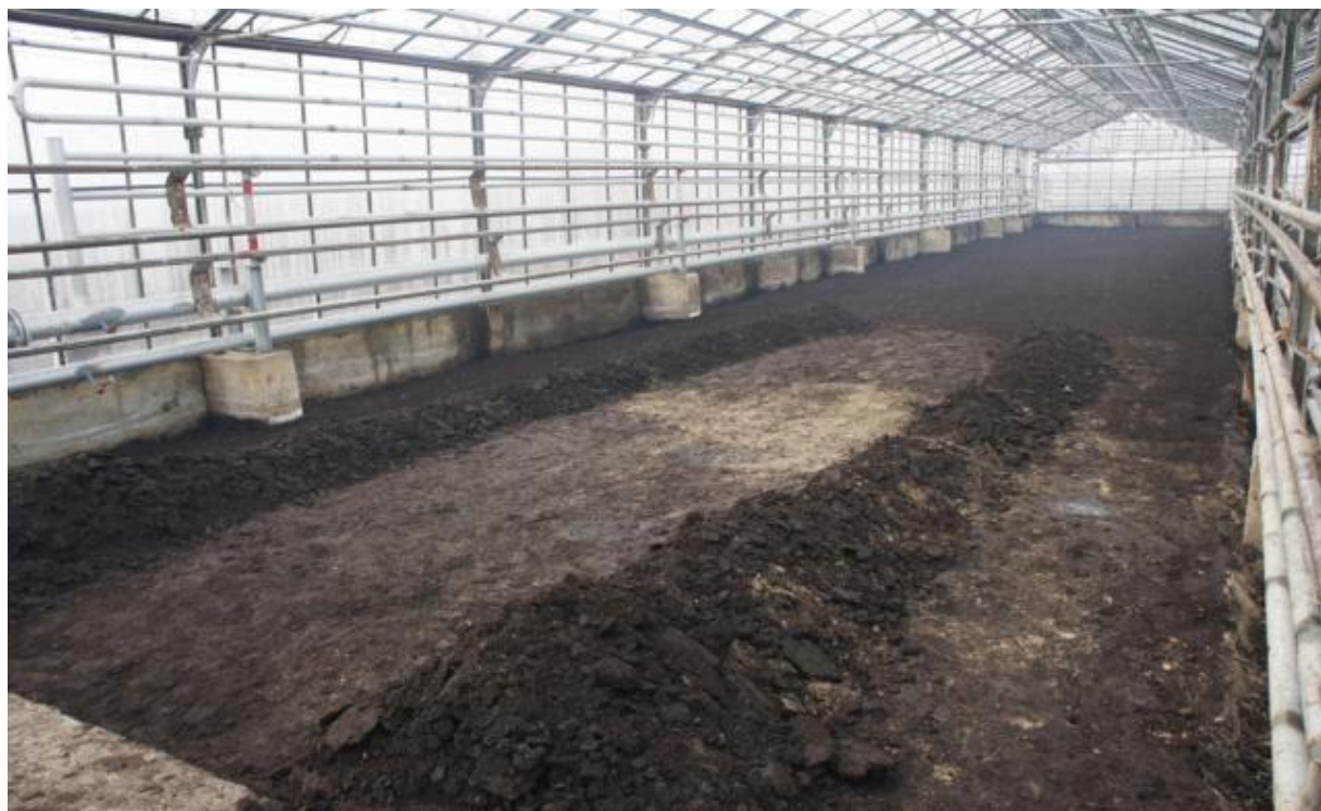
Рисунок 1.4 – Общий вид процесса укладки типичного грунта
